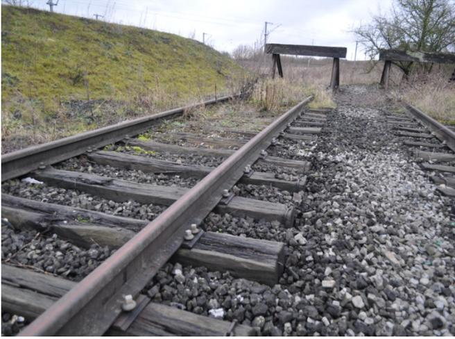
Sur la photo ci-contre, on perçoit les deux heurtoirs sur les deux voies qui composaient le raccordement vers Reims (on perçoit également l'état des traverses et du ballast).
