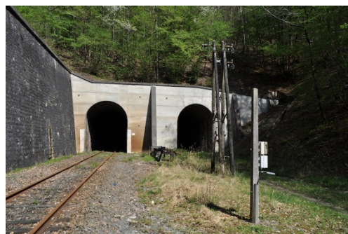
Entrée du tunnel des Islettes nord, côté Sainte-Ménéhould. L'entrée de droite recevait la 2 ème voie qui a été déposée.
